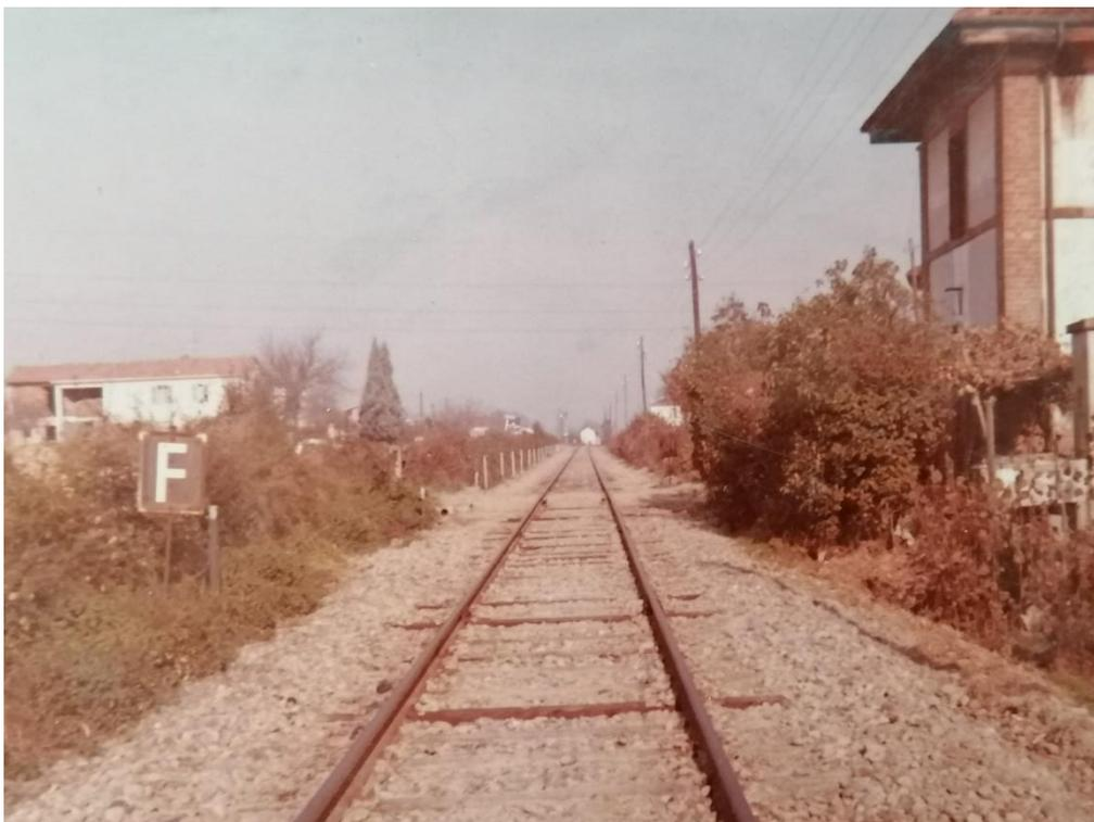
*Foto dell'Ufficio Lavori Torino, Reparto di Nizza Monferrato, che ci descrive la linea Asti-Chivasso presso il km 4+500 circa (rettilineo tra Asti e Sessant) ancora armata con il vecchio binario con rotaie RA ("Regio Armamento") da 36 kg/ml. Sessant, 5/11/1974, per gentile concessione di Mario Cresta*
