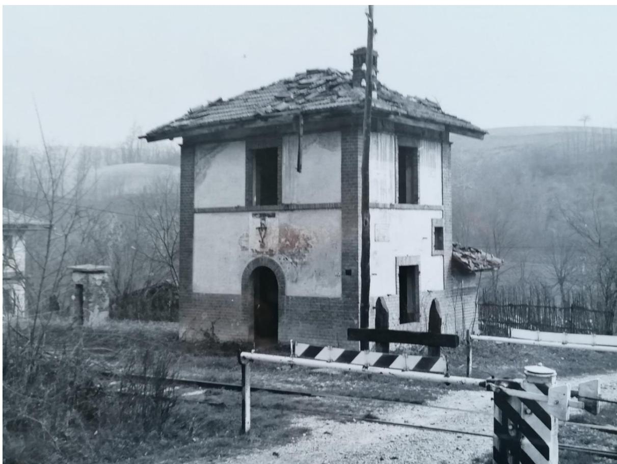
*Casa cantoniera nei pressi di Cavagnolo-Brusasco con passaggio a livello al km 34+179: si noti il sistema della suoneria del passaggio a livello mediante "piatti" e manovra a filo. Da archivio Ufficio Lavori FS Torino, foto Studio Bressano anni Settanta. Per gentile concessione di Mario Cresta.*
